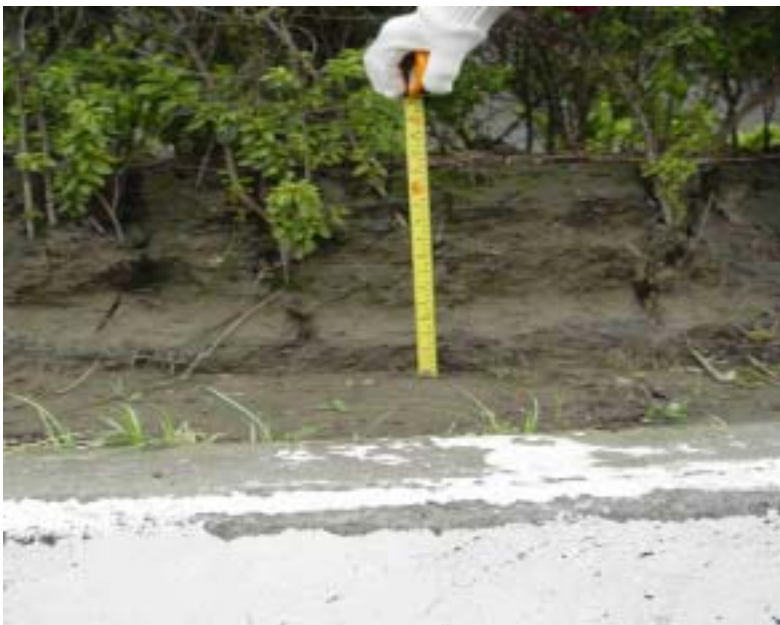
照片丙-3 疏洪道測水災沉積厚度
