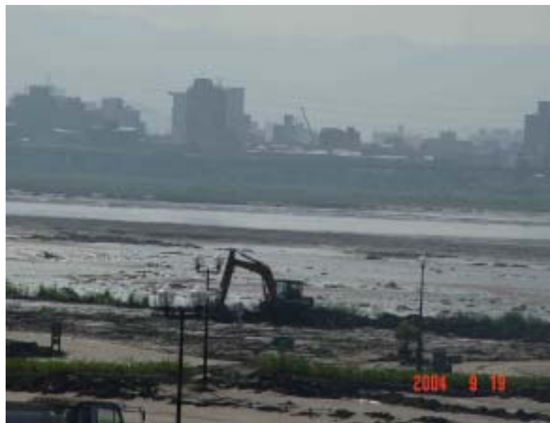
照片丙-5 二重疏洪道沉積
