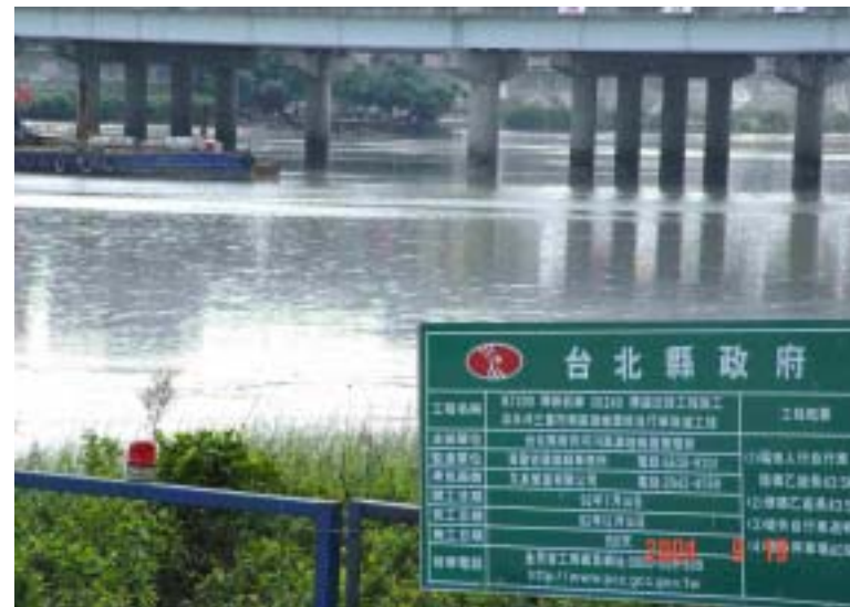
照片甲-4 台北橋下捷運工程
