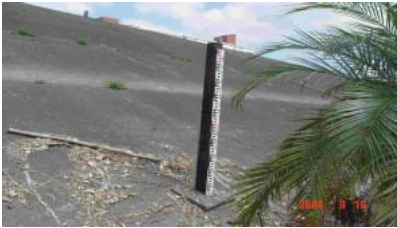
照片丁-3 疏洪道堤防上水位斜坡
