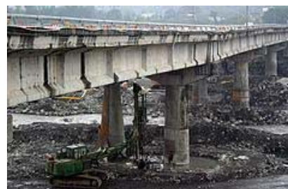
高雄縣六龜大橋橋墩是圓形
