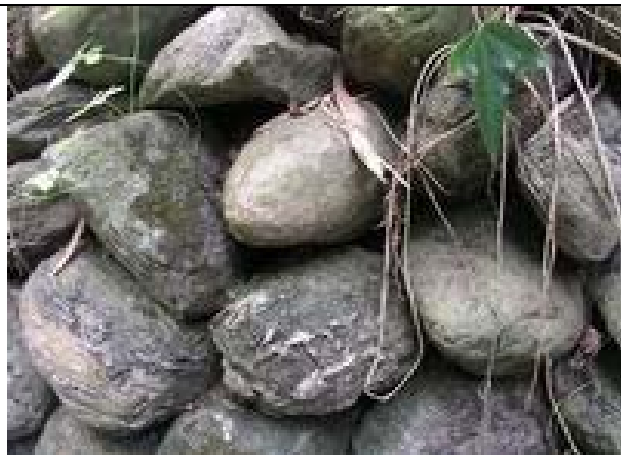
圖 12、砌石：標準的砌石，三角洞成 z 字型，這樣砌石才有咬合力，不容易垮掉。
