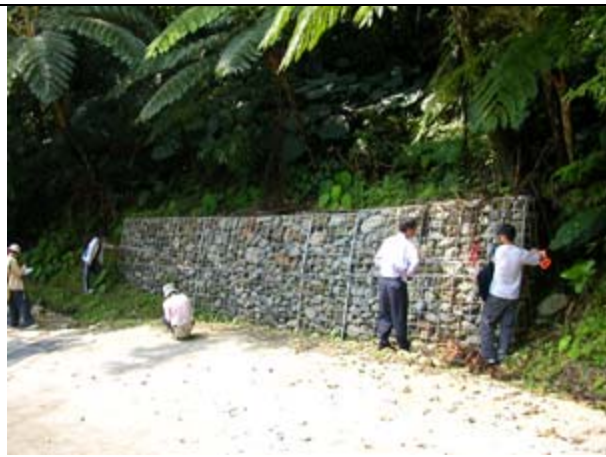
圖 16、石籠：在佐倉的石籠，將石頭放置以鐵絲綁好的框架內，框架內還有塑膠網。
