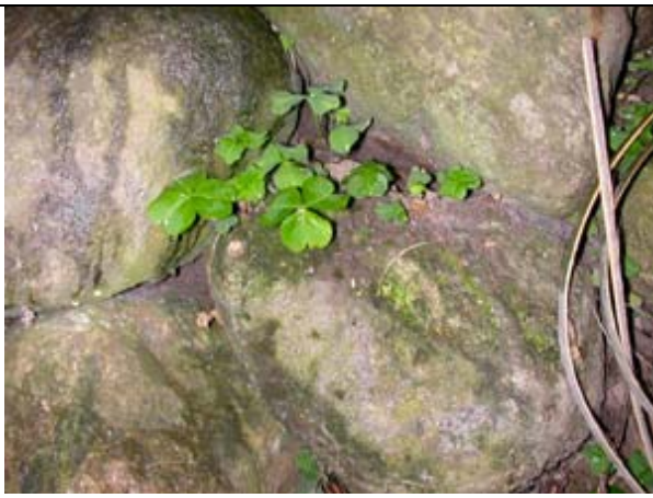
圖 13、以石頭堆疊成的砌石，留給動植物生存的空間。
