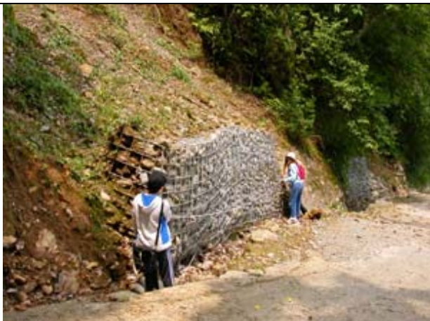
圖 17、框架加塑膠網及石頭，仍敵不過土石的威力。
