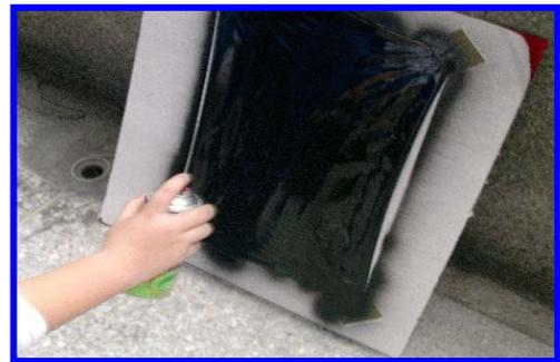
圖 26 在塑膠膜上噴漆製作鏡面
