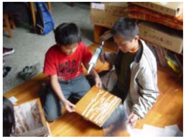
圖 5.3 牆面塗抹 SILICONE 粘膠情形
