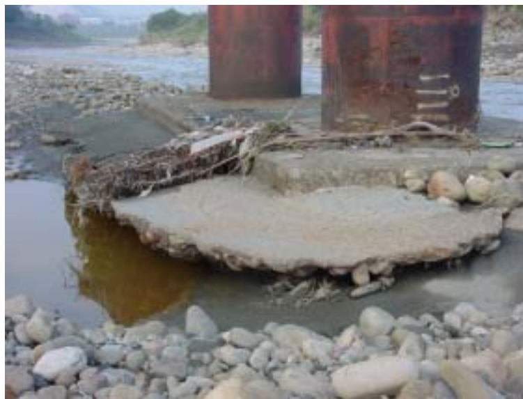
（照片 B-丙-1）橋柱的束縮沖刷
