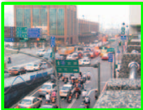
照片-15：延伸中正高架道路 成為立體交叉路口
