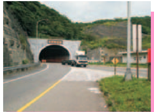
照片-11：隧道出口即有交流道，造成極大的危險
