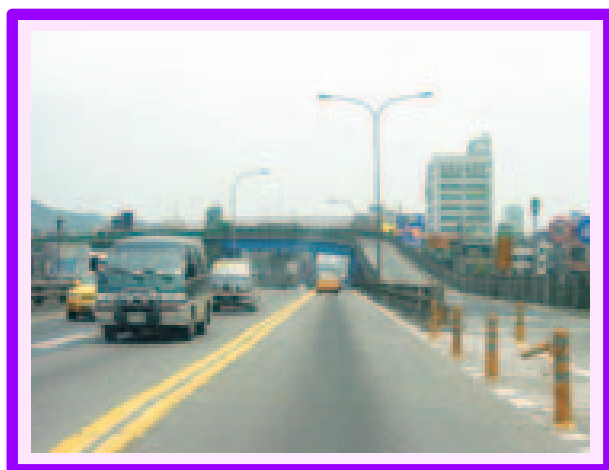
照片-24：將西岸高架橋改建移為左線車道
