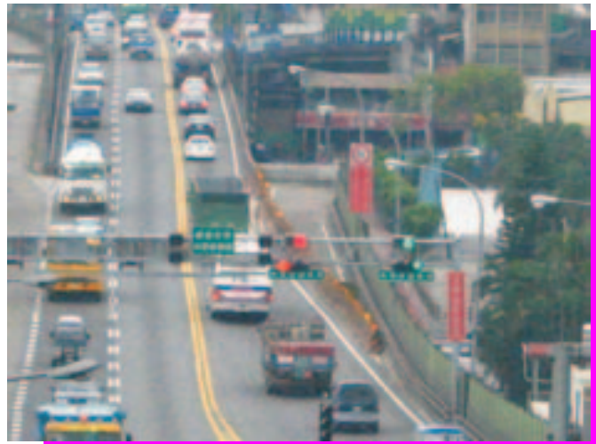
照片-04：拆除西岸高架橋車道縮成一線
