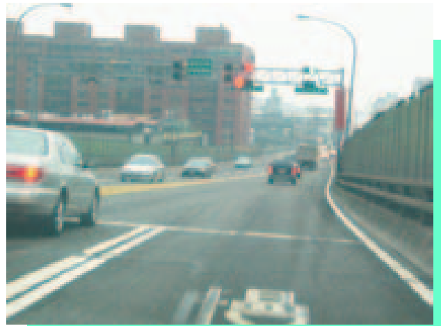
照片-06：設置燈誌管控車序
