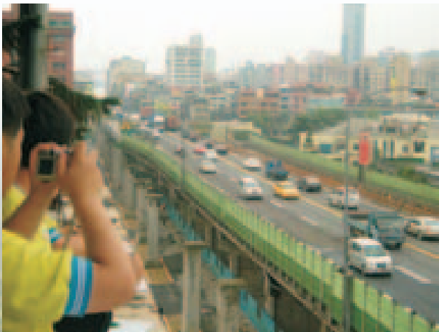
照片-07：西岸高架橋拆除後景觀
