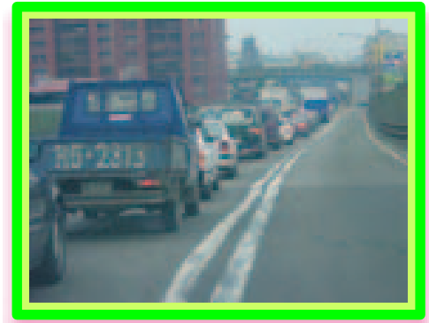
照片-18：西岸高架橋未拆除前
