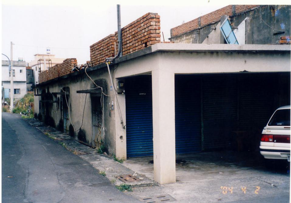
(圖八) 房屋側面的下窗緣已沉入地下。
