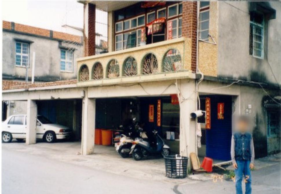
(圖十五) 右邊的二樓建築物下陷程度較左邊二間平房多，中間平房的橫樑已被扯裂。
