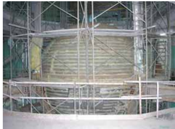
(上圖為大樓 92 樓所掛重達 680 噸的大球(抗風制震重球—風阻尼器))
