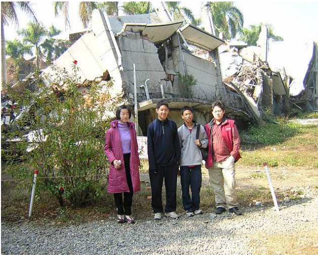
921 地震倒塌的建築物
