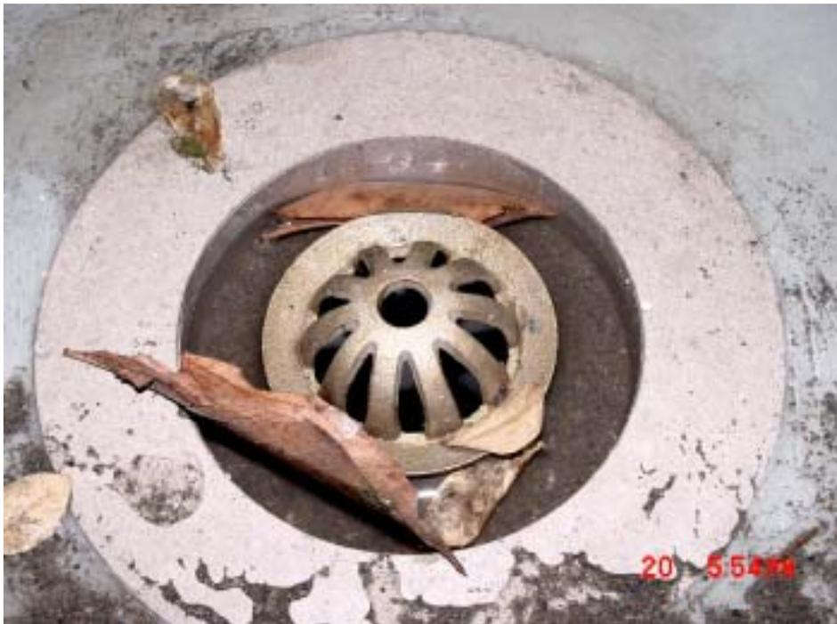
圓頂式落水孔蓋阻擋樹葉的情形
