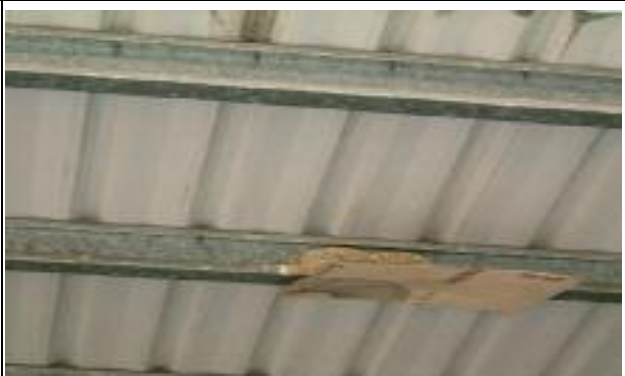
北埔地區家燕築在屋簷下的鋼條上。
