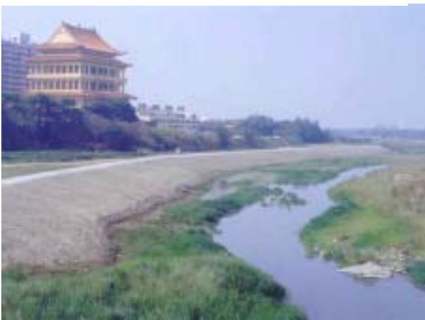
圖十七：2003.3 月靠近軍輝橋河段防洪工程完工全貌。
