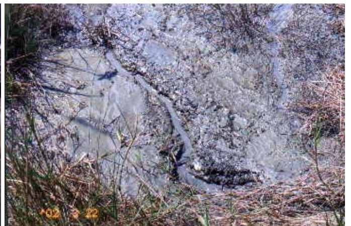
照片 6 噴泥口的排水口
