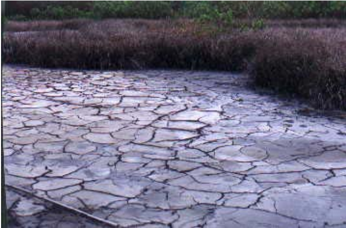
照片 7 土表乾燥後產生的龜裂
