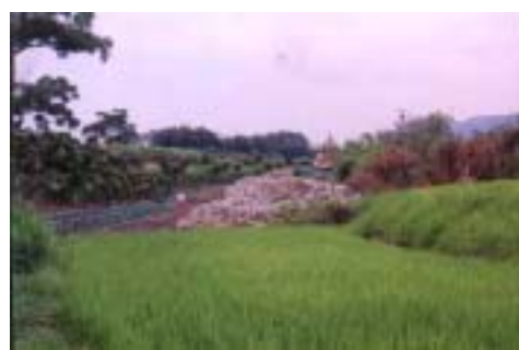
照片 58 工程施工中，挖土機就在泥火山地區輾壓
