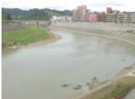
照片 15：實踐橋到百福橋左側淤泥
