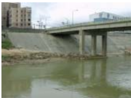
照片 9：百福橋左側（完工）
