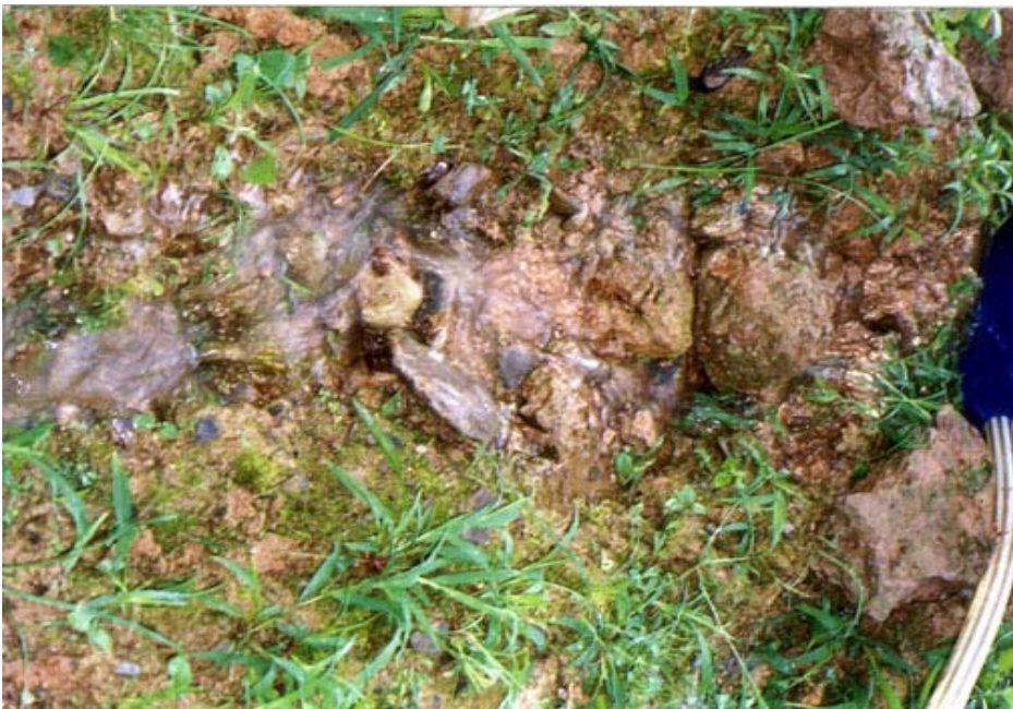
圖十一 河床破壞土壤繼續流失
