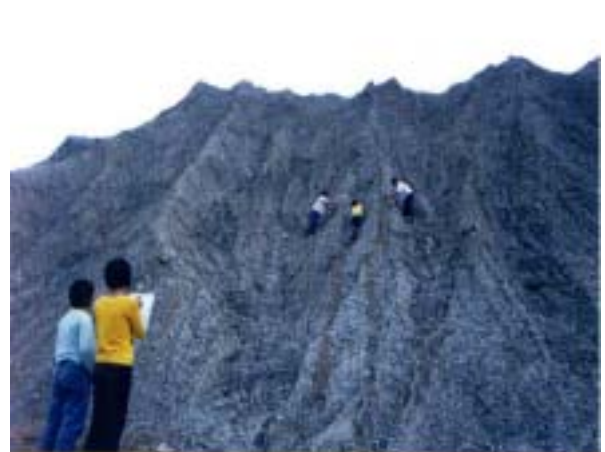
照片 5 蝕溝計測情形（側向坡）
