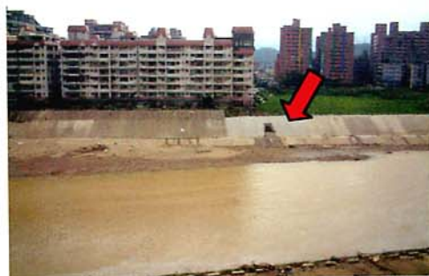
▲照片一 警戒線(排水孔)
