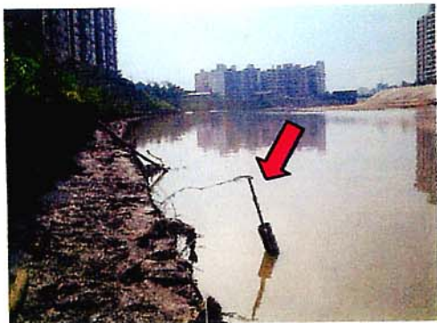
▲照片三 自動水位紀錄儀
