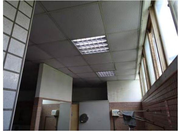
圖 15 廁所中多個燈座由一個開關控制
