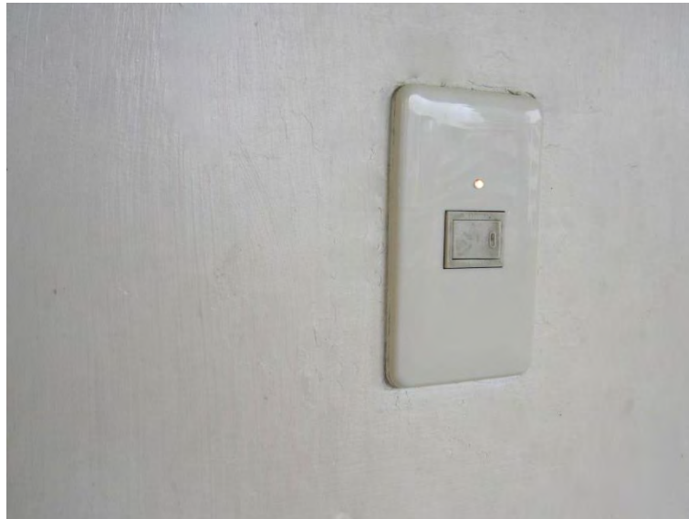
圖 29 實際安裝於牆壁上測試
