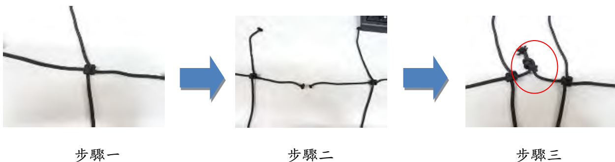
圖五、第二代自製安全護網步驟流程圖。
