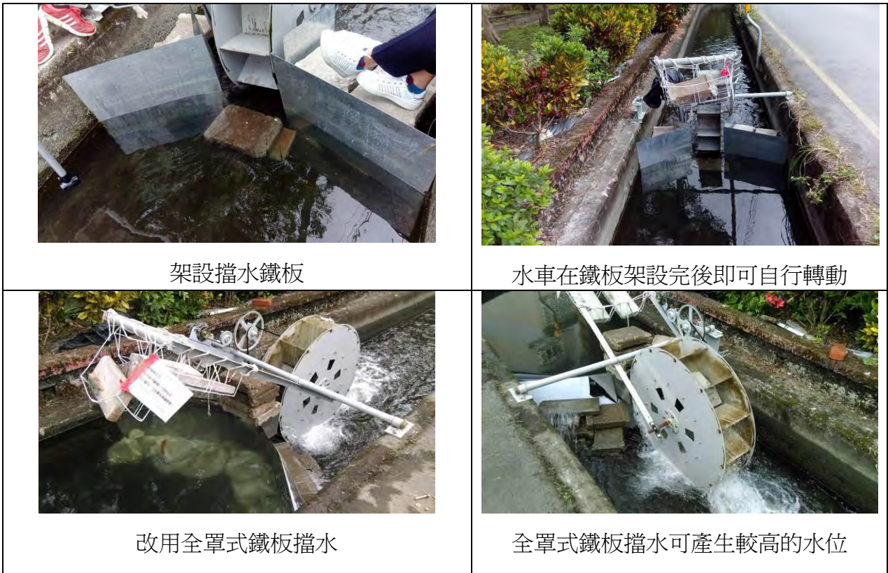
圖 8 在水車前架設擋水鐵板。
