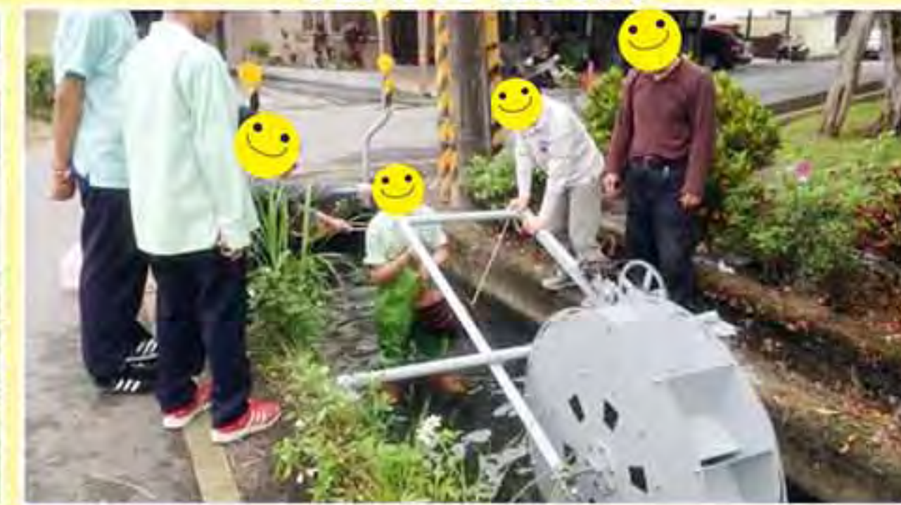
完成現場安裝
