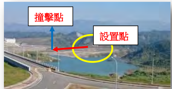
圖 37 水庫可能的異重流設置與撞擊點
